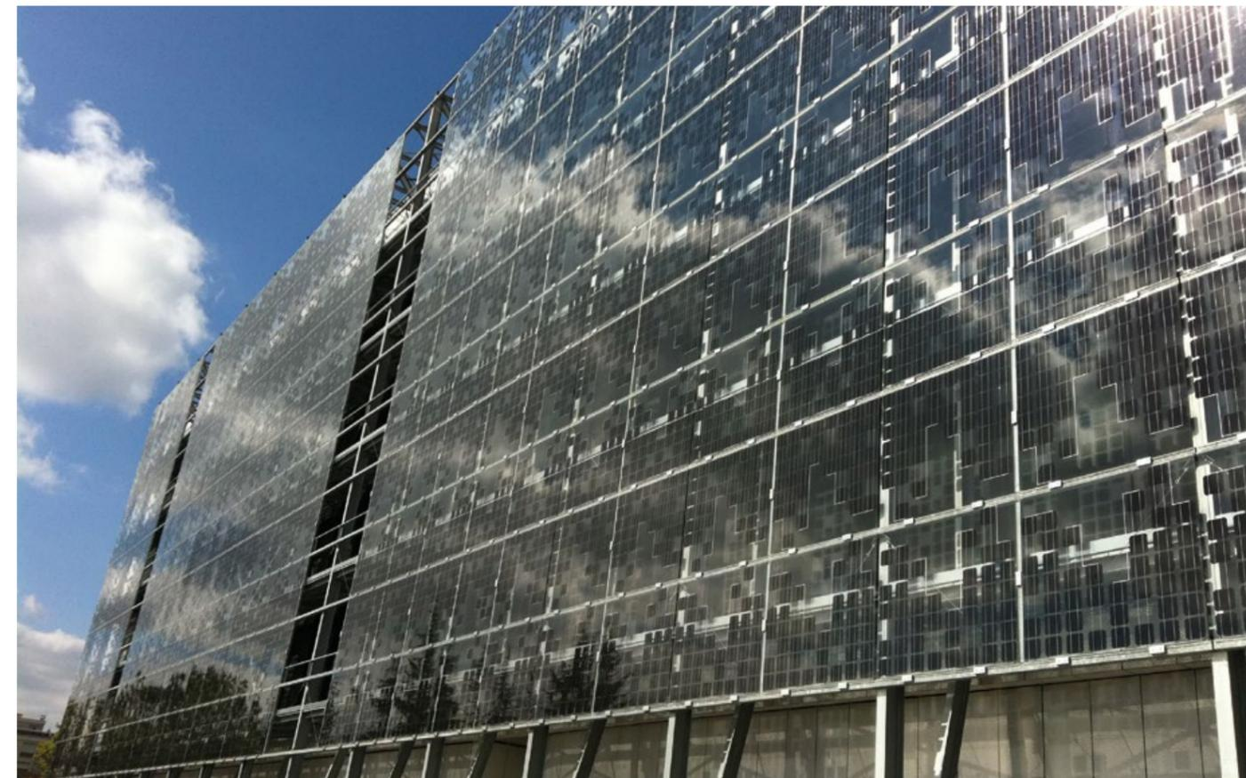
attualmente tali batterie hanno ancora un costo molto elevato e quindi in genere gli impianti sono collegati alla rete. **Ogni pannello di un impianto fotovoltaico è costituito da celle solari ottenute da lamine sottili di materiali semiconduttori.** Tali materiali hanno la capacità, se vengono colpiti da onde elettromagnetiche come la luce del sole, di generare una determinata tensione elettrica tra la superficie irradiata e quella non esposta.
